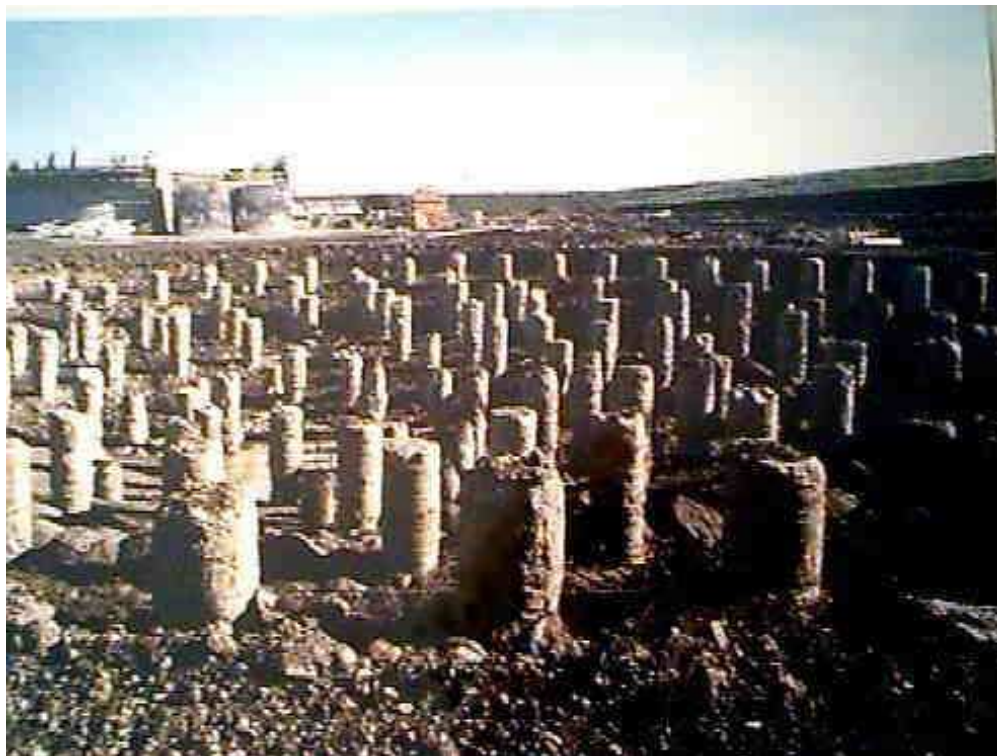
FONDAZIONE SERBATOIO DI DIGESTIONE ACQUE REFLUE - ALGERI
