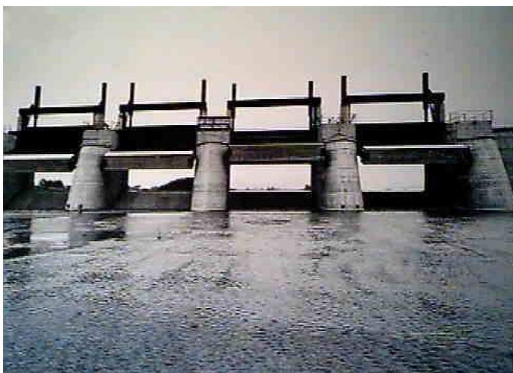
DIGA DI RICARICA ARTIFICIALE VALCONCA
