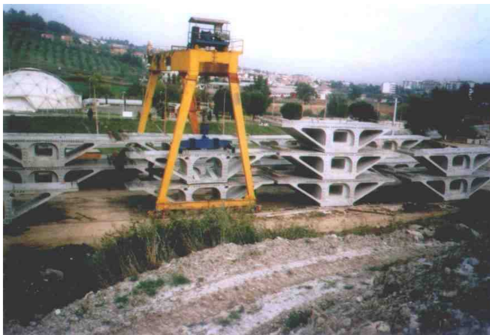
VIADOTTO CAMPAGNANO STOCCAGGIO CONCI - COSENZA AUTOSTRADA SA-RC
