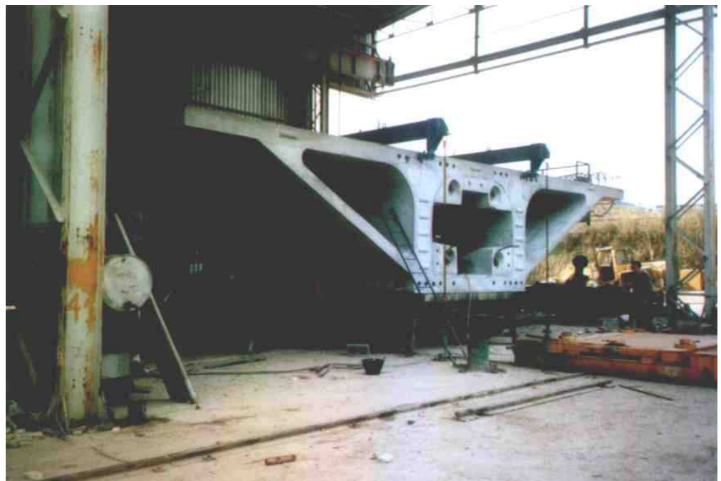
VIADOTTO A CONCI CAMPAGNANO SVILUPPO 1208 MT COSENZA AUTOSTRADA SA-RC
