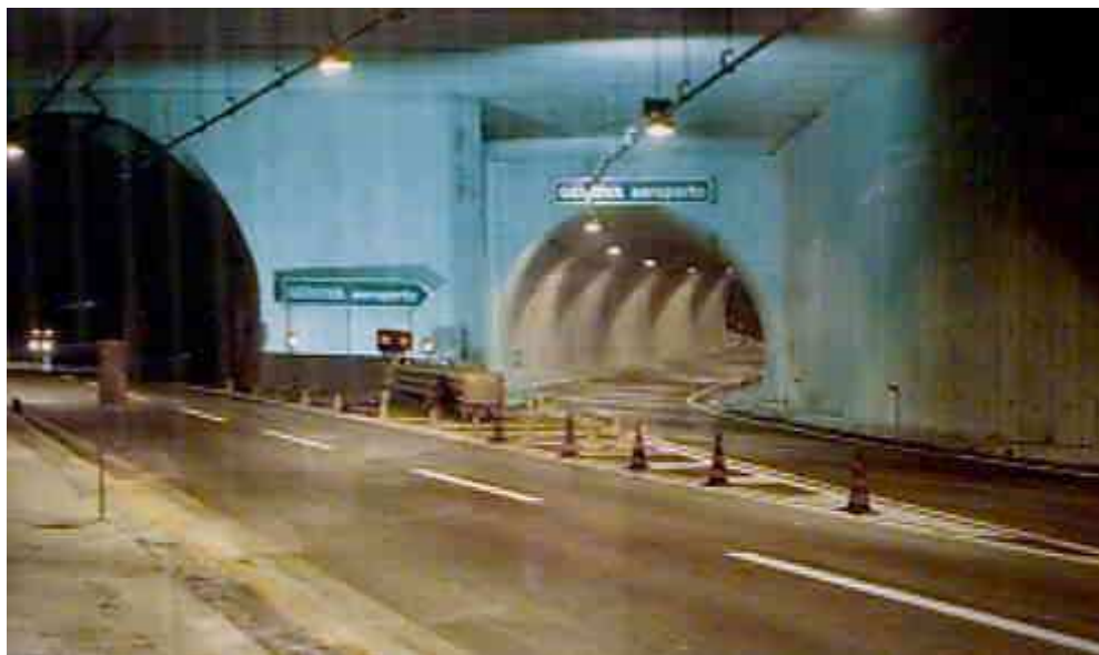
SVINCOLO GENOVA – AEROPORTO - PARTICOLARE
