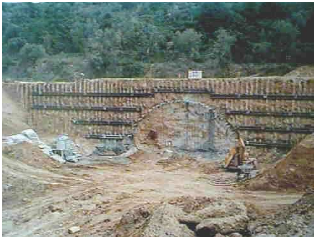
SVINCOLO AUTOSTRADALE DI ALBENGA
