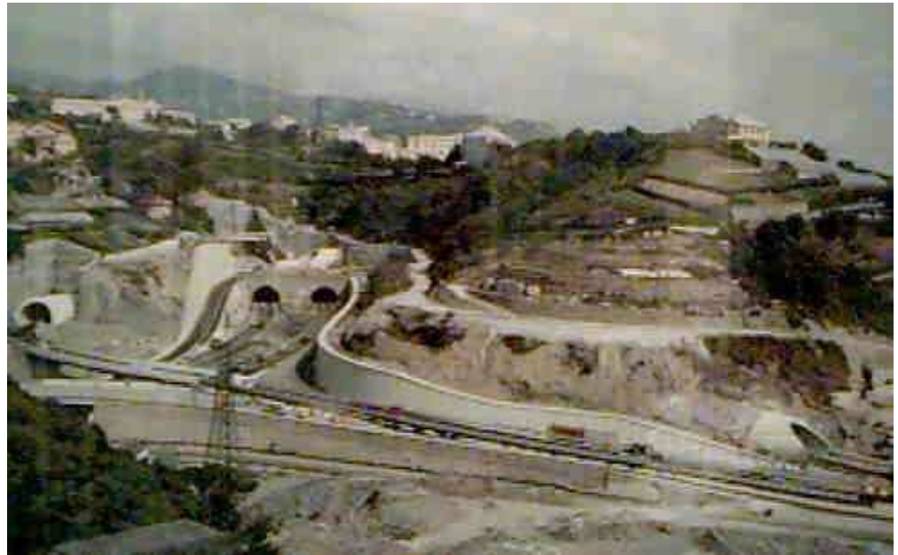
SVINCOLO GENOVA – AEROPORTO – VEDUTA GENERALE
