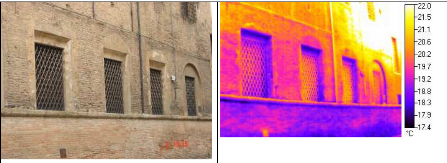
Indagine termografica svolta all'esterno del palazzo Orsi di Forlì.
